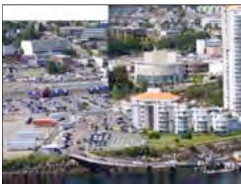
A. GABRIOLA FERRY TERMINAL
